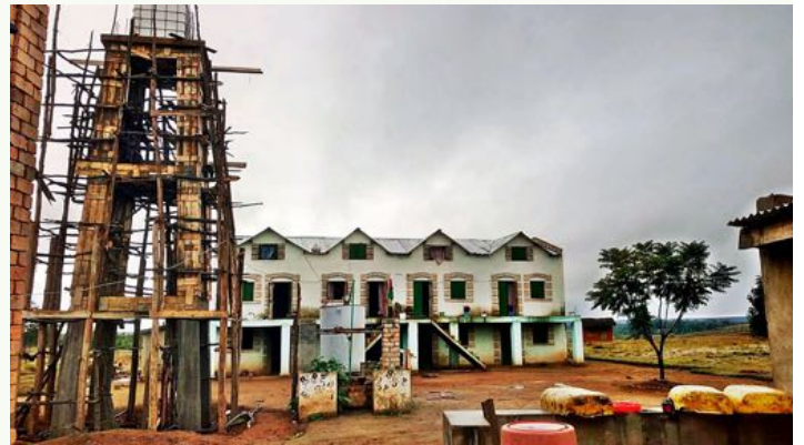
Kélilalina et son château d'eau en construction
