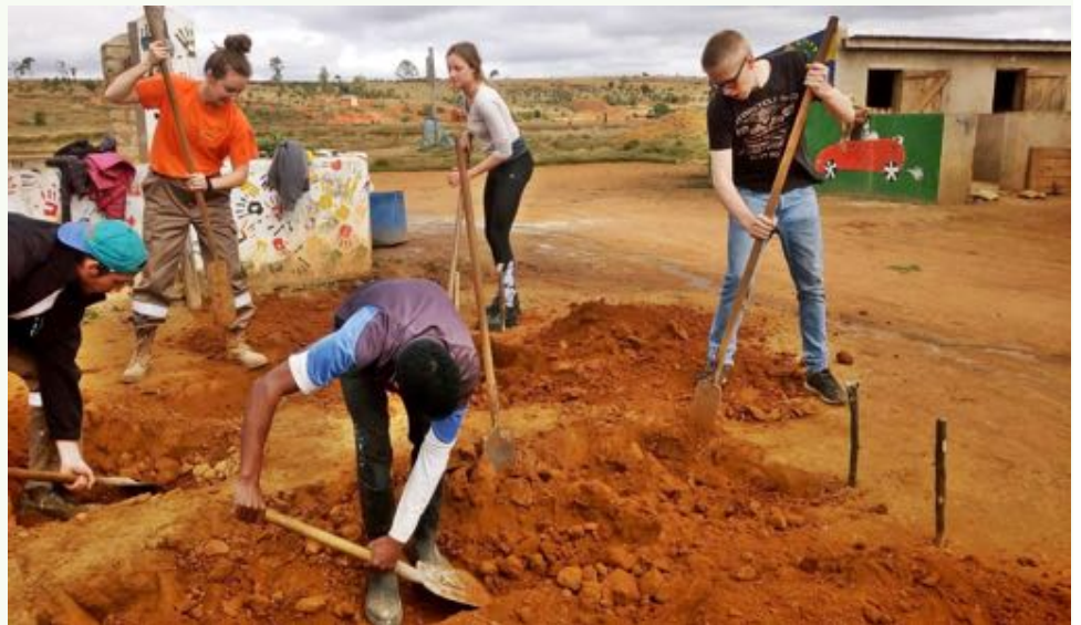
D'abord creuser les fondations pour garantir la pérennité du château d'eau
